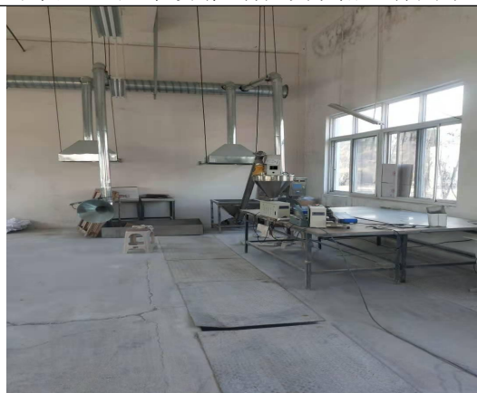
固体制剂包装车间一车间集气罩
