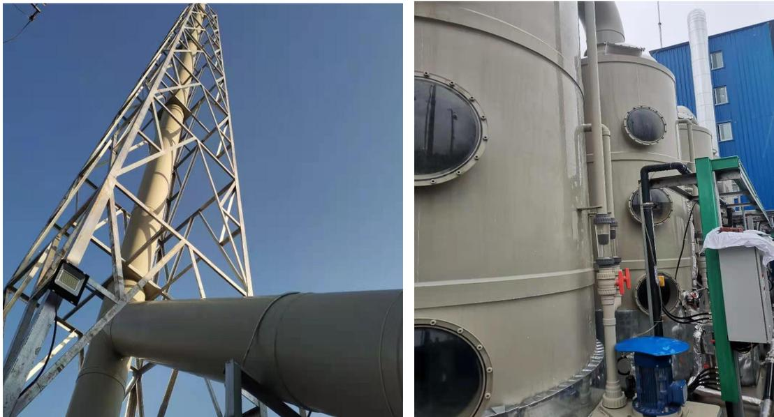
图 3-3 废气处理设施及排气筒照片
