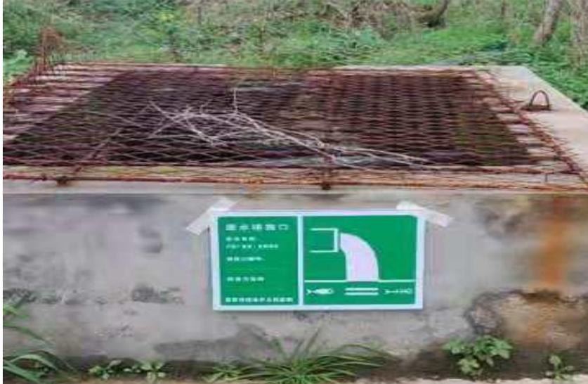
图 3-1 项目废水总排口取样处（PVC 管道接入合肥嘉园水处理投资有限公司现有排水井）
