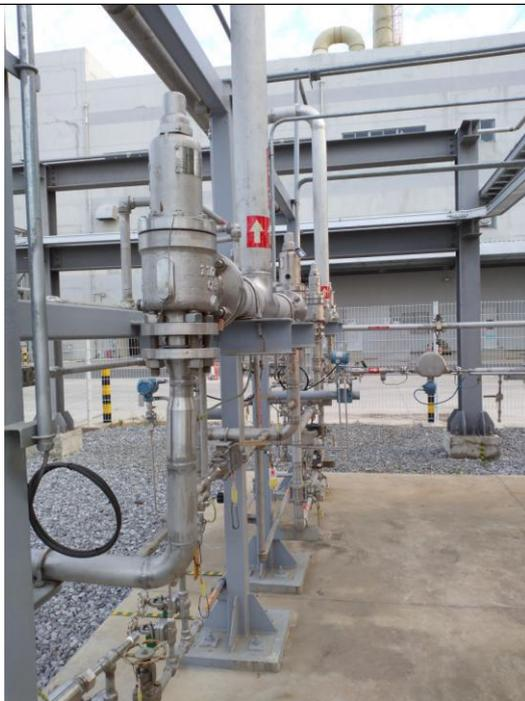
减压阀、安全阀、氢气探测器
