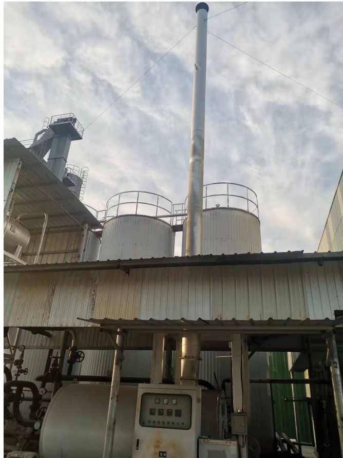
导热油炉废气排气筒 P3
