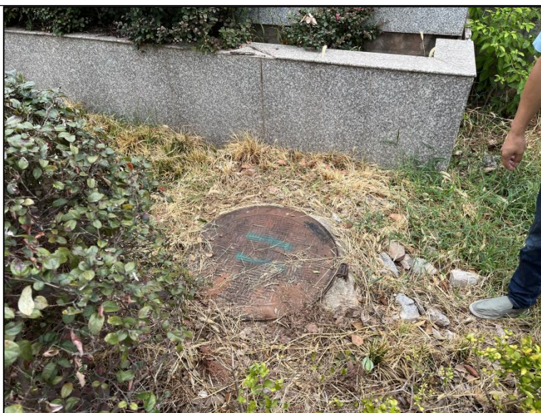
图 3-1 厂区污水总排口
