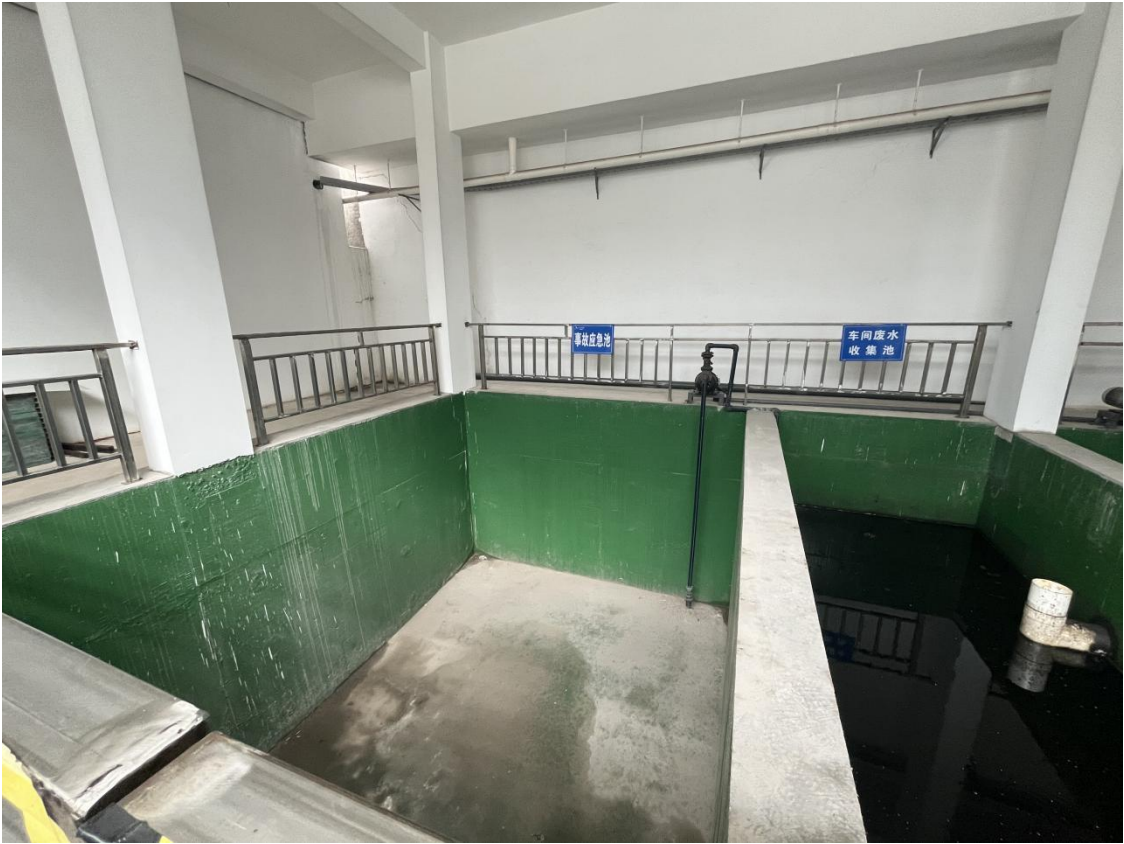
图 3-6 厂区事故应急池照片
