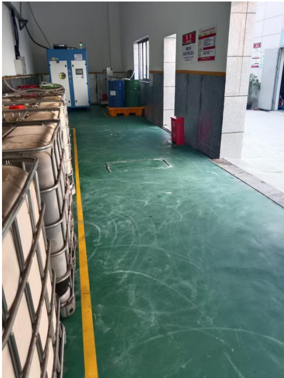
图 3-7 低温蒸发器设备房环氧地坪地面照片
