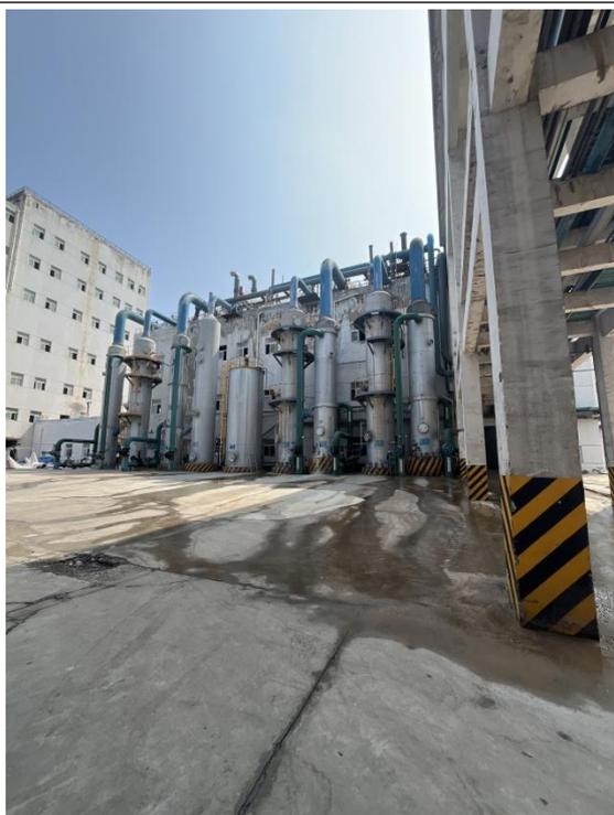
煅烧工序旋风除尘+水封槽+炉气冷凝塔+炉气洗涤塔
